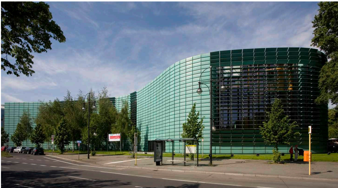
Bild 14 Fassade aus vorpatinierten Kupferlamellen.
