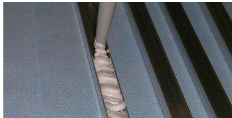
Bild 4 Einbringen einer Dichtungsmasse in eine Aluminium-U-Profil-Schiene
