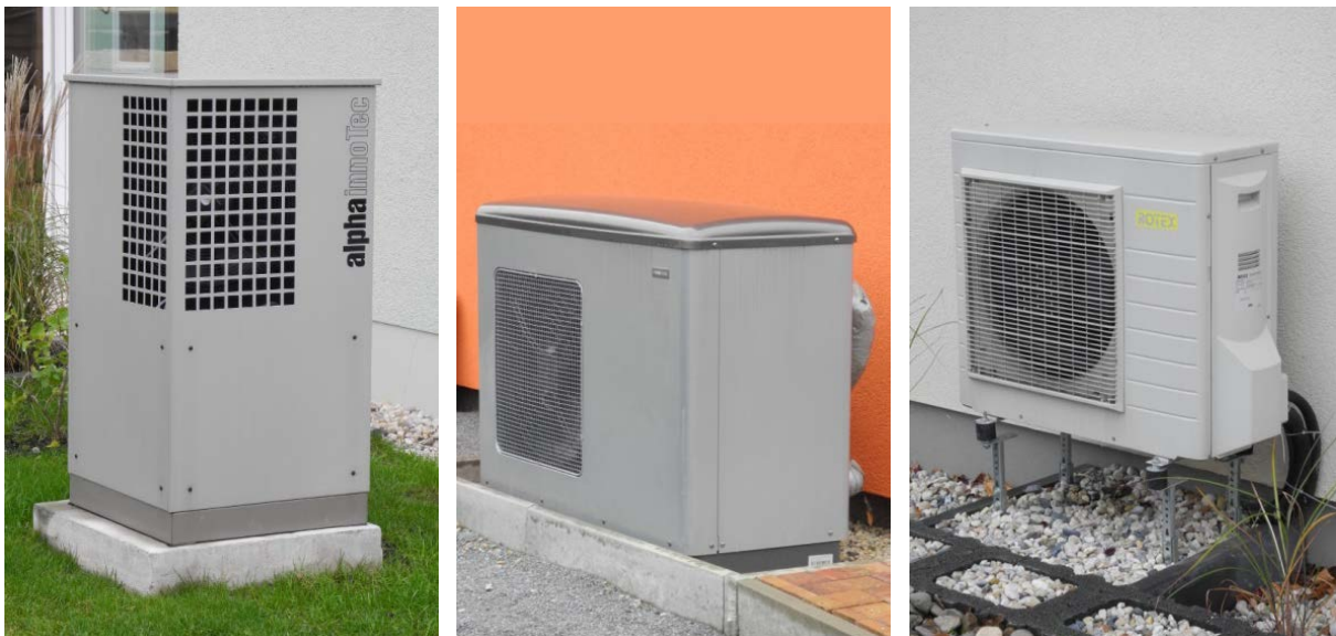
Abbildung 3: Außeneinheiten von LWWP verschiedener Bauweise
