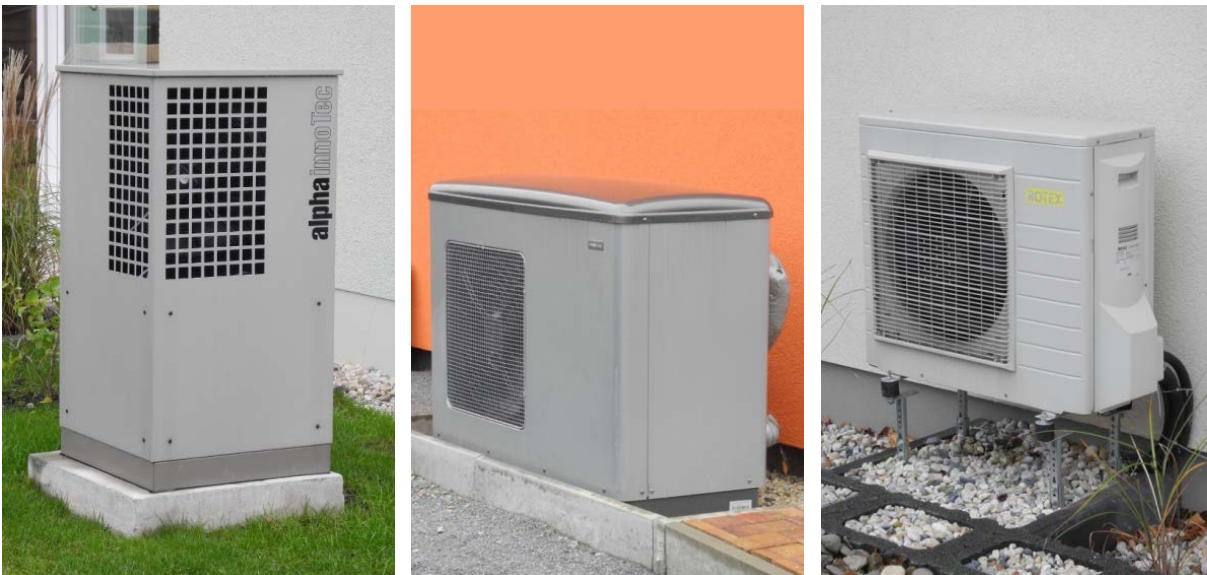
Abbildung 32: Außeneinheiten von LWWP verschiedener Bauweise
