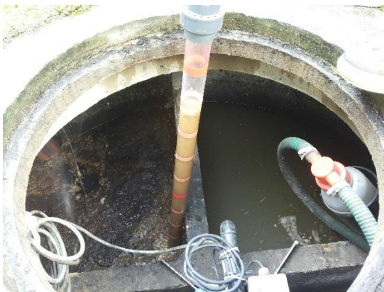
Abbildung 3: Probenahme an einer KKA
