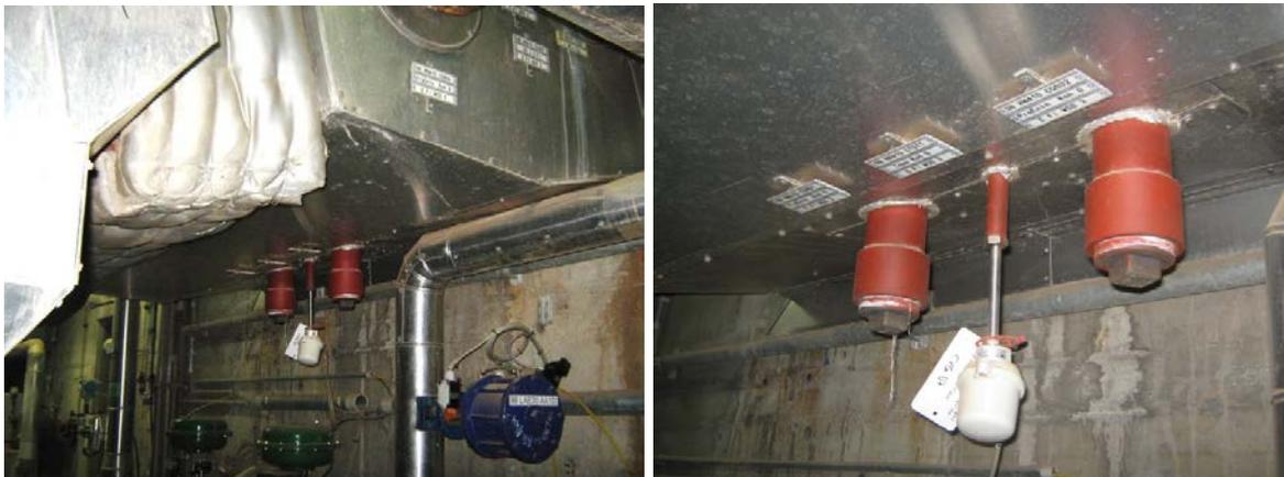
Messstelle Abgasbeprobung: Messstelle 1 nach Kessel
