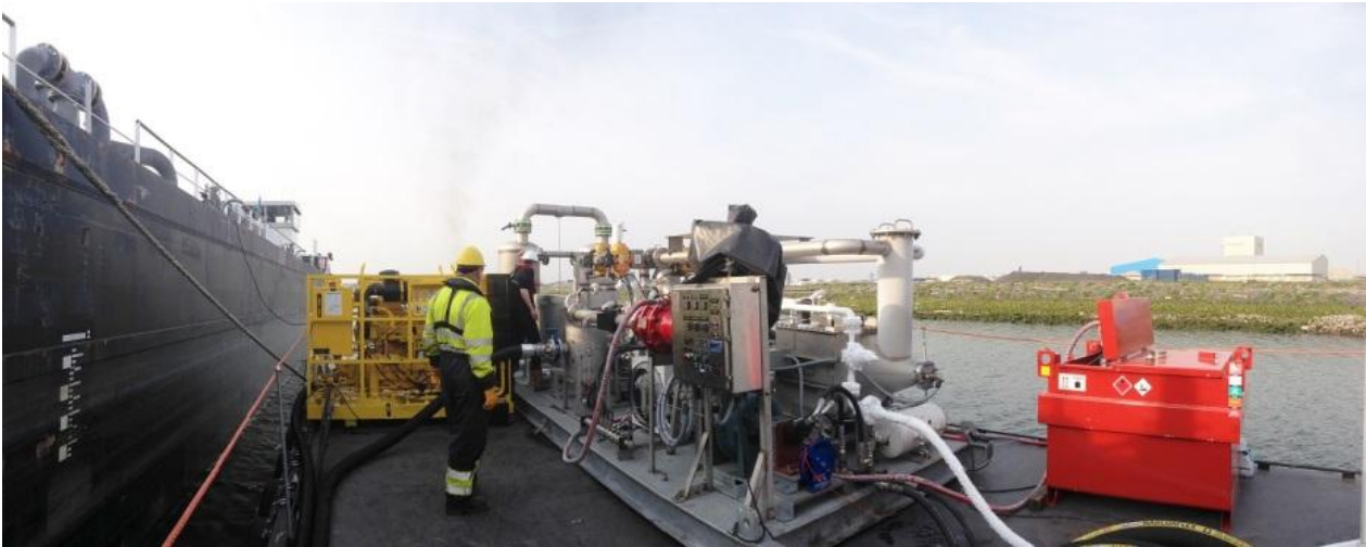
Abbildung 17: MariFlex Group-Kondensationsanlage im Hafen Rotterdam (Foto: MariFlex Group)
