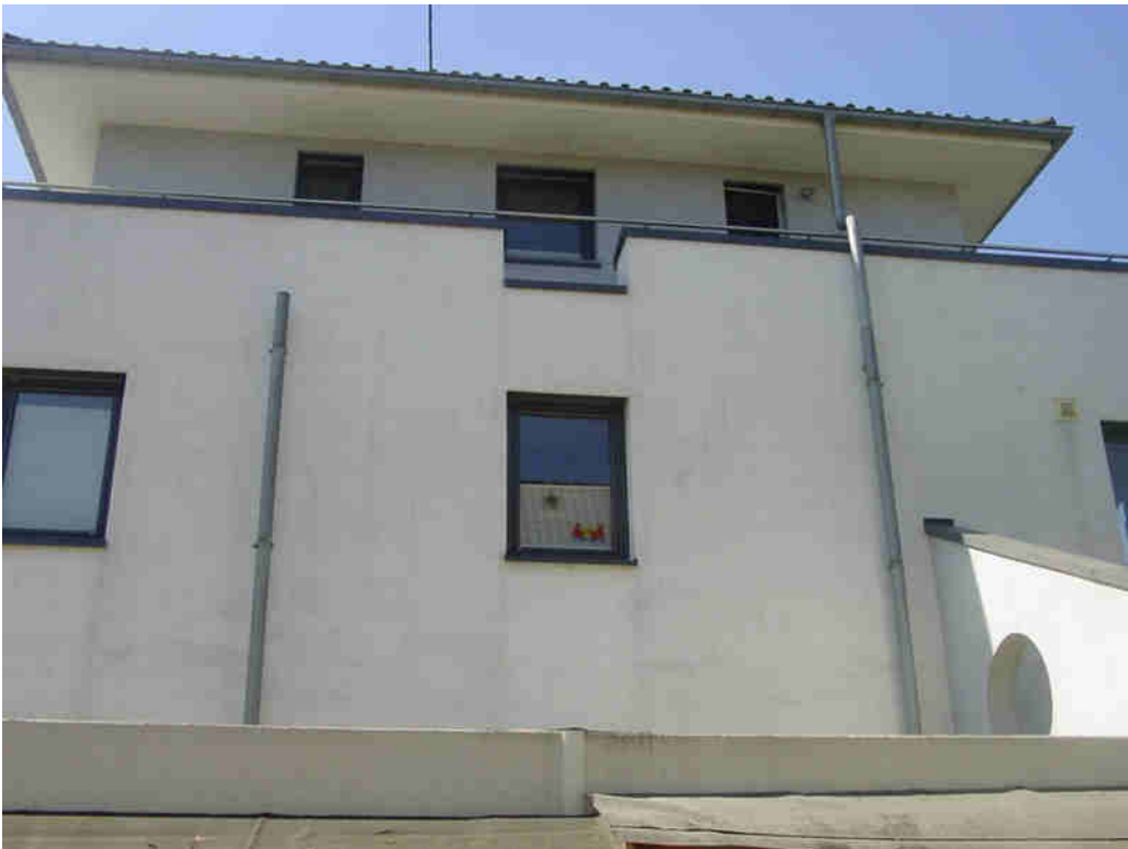
Abbildung 55: Objekt 42 mit Bereichen mit (oben) und ohne Dachüberstand (unten). Im unteren Bereich ist eine deutliche Verschmutzung der Fassade erkennbar.
