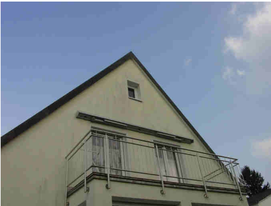
Abbildung 56: Objekt 365 mit typischen Ablaufspuren auf der Südseite des Gebäudes.
