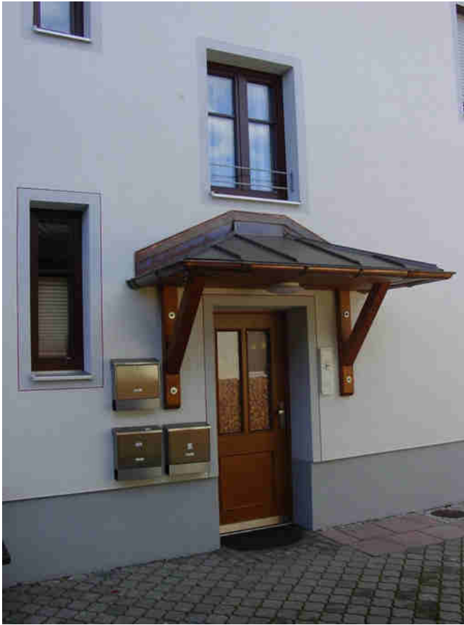
Abbildung 53: Objekt 121 mit der nachträglich verputzten Stelle, wo die Gerüstverankerung angebracht war.
