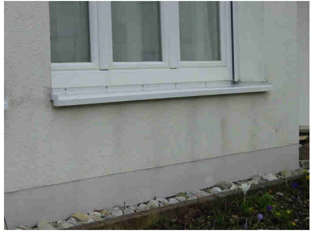
• Ablaufspuren Anbau Südseite
