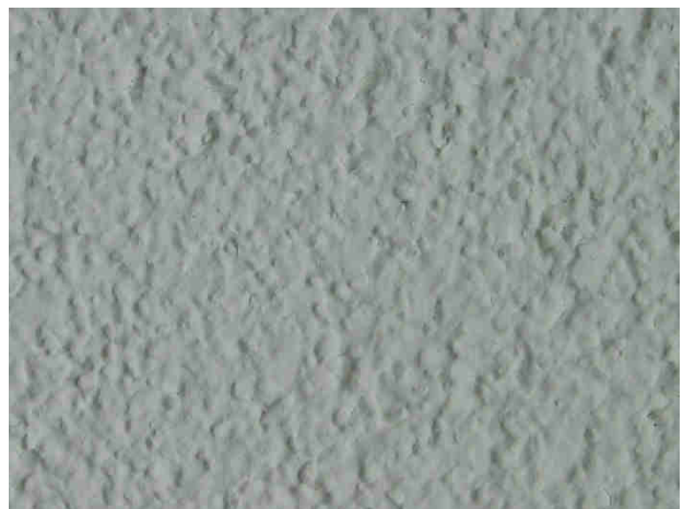
• Detail, kein Aufwuchs erkennbar
