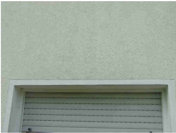
• Aufwuchs über dem Fenster, N-Seite
