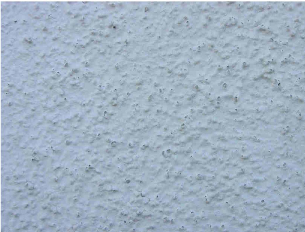
Abbildung 50: Objekt 116, kleine Beschädigungen in der Farbschicht, die das Strukturkorn des Oberputzes freilegen.
