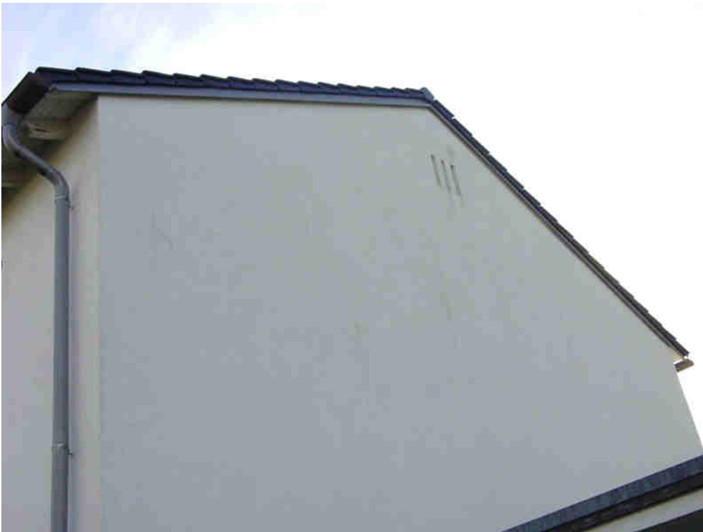
Abbildung 51: Objekt 116 mit Ablaufspuren, die von kleinen Beschädigungen der äußersten Gebäudeschicht ausgehen.
