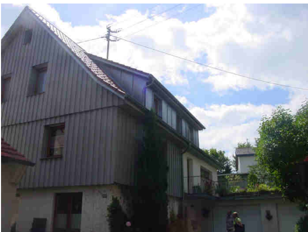
• N-und O-Seite (nicht gedämmt)
