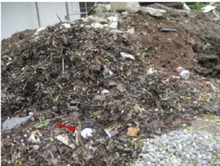
Abbildung A1 - 24: Abfälle der Sanierung einschließlich Fugenmasse sind auf dem Gelände verstreut
