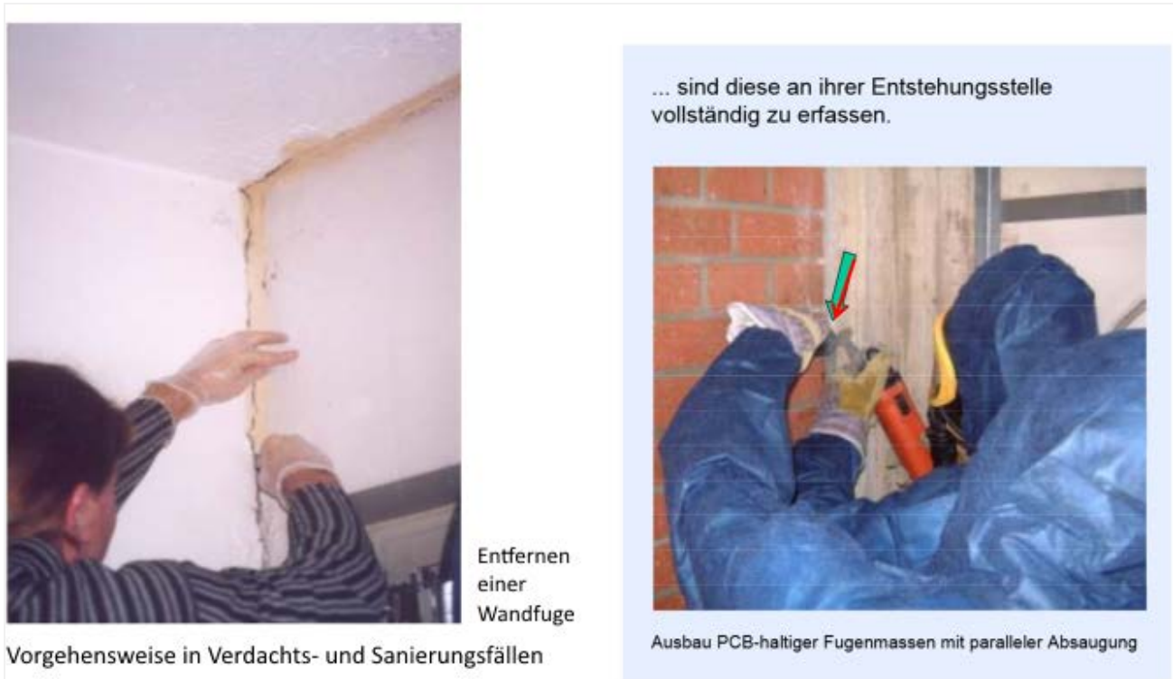
Abbildung A1 - 26: Entfernen PCB-haltiger Fugenmassen. Links: Herausschneiden einer potenziell PCB-haltigen Fuge ohne ausreichenden Personenschutz. Rechts: Fachgerechter Ausbau von PCB-haltigen Fugenmassen unter paralleler Absaugung
