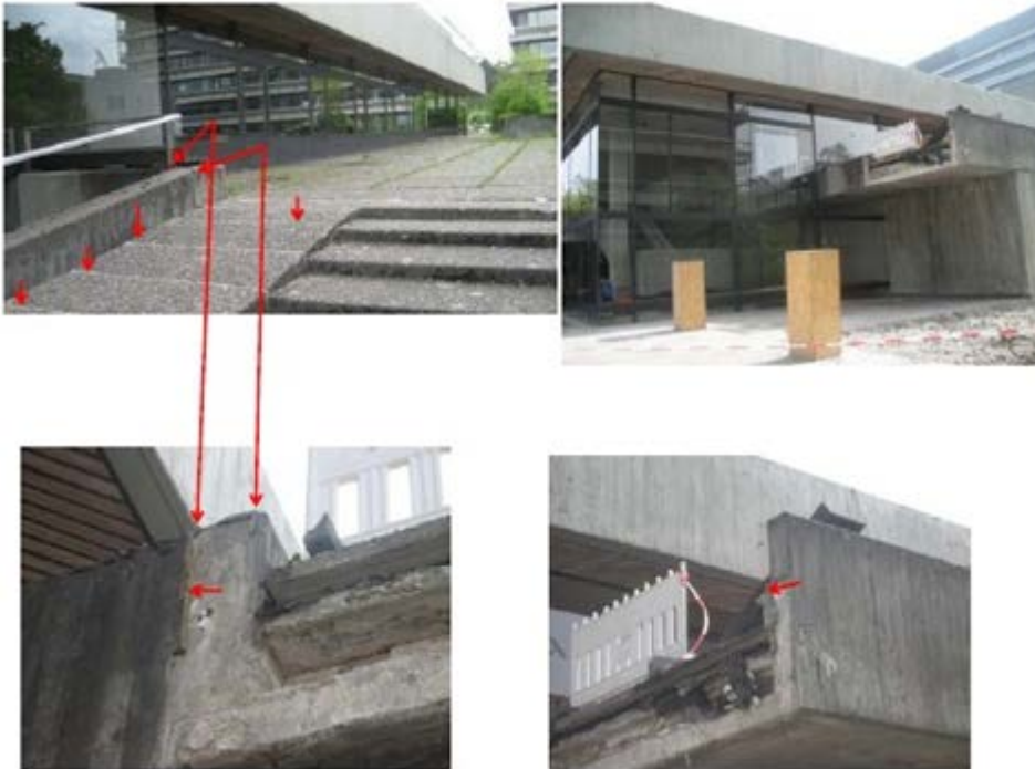
Oben: Treppe mit Rampe im Jahr 2010; Rechts und unten im Jahr 2013. Fotos: C. Herold
