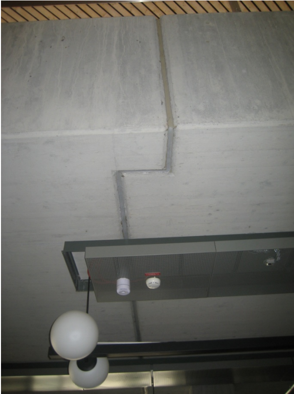
Abbildung A1 - 16: Decke des Hörsaalzentrums nach der Sanierung mit neuen Rauchmeldern über einer alten PCB-Fuge
