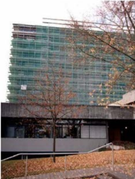
Abbildung A1 - 14: A-Bau nach dem Abstrahlen
