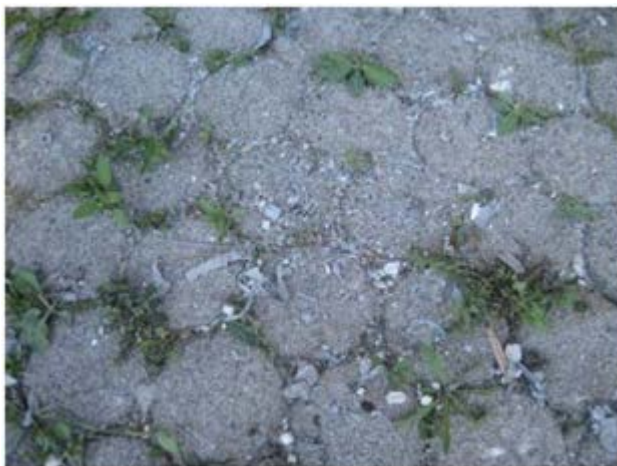
Abbildung A1 - 7: Nicht sachgerecht entsorgte Fugenmassen, die nach Beendigung der Sanierungsarbeiten am Boden zurückgelassen wurden
