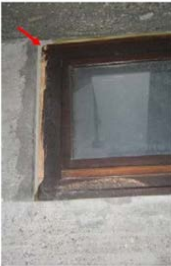
Abbildung A1 - 23: Die Oberflächen der Fugenmassen um die Fenster wurden beim Abstrahlen zum Teil abgetragen
