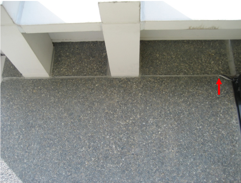
Abbildung A1 - 15: Teil der Fassade des A-Baus nach der Sanierung mit neuer Stromleitung in der PCB-Fuge
