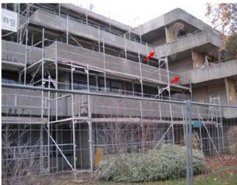
Abbildung A1 - 22: Gebäude nach dem Abstrahlen. Grauer Staub liegt in der Umgebung
