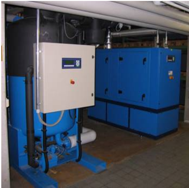
Abbildung 62: Kraft-Wärme-Kälte-Kopplung mit BHKW (linkes Bild, rechter Bildteil) und Absorptionskältemaschine (linkes Bild, linker Teil) zur Klimatisierung eines gewerblichen Gebäudes (rechtes Bild) (Weidner 2008)
