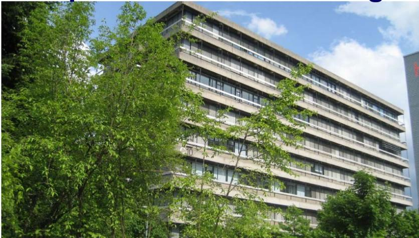
Inventar eines Universitätsgebäudes (C-Bau Physik) vor Sanierung (2005): mehr als 1 t PCB in Fugenmassen, Deckenplatten und Anstrichen verbaut. Die 12000 m<sup>2</sup> Wilhelmi-Deckenplatten mit ca. 500 kg PCB (4 g PCB-TEQ).
