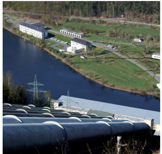
Pumpspeicherkraftwerke können sowohl verbrauchs- als auch erzeugungsseitig zur Steuerung des Stromversorgungssystems beitragen. (Foto: Marco Barnebeck / pixelio.de)
