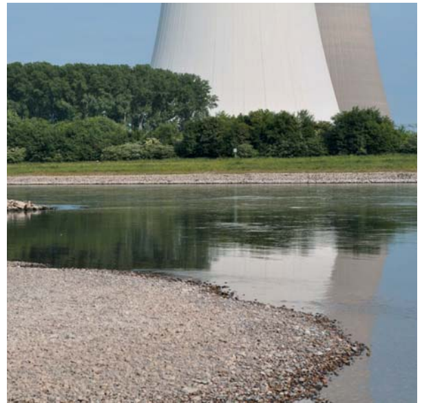
In heißen und trockenen Sommern kann es zu Schwierigkeiten bei der Entnahme bzw. Einleitung von Kühlwasser kommen. (Foto: Siegfried Kremer, Phillipsburg)
