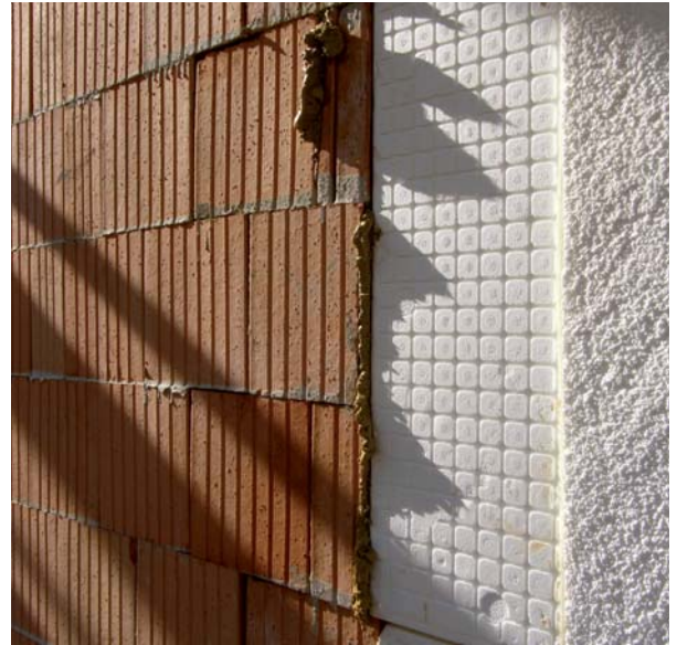
Eine gute Gebäudeisolierung schützt auch vor sommerlicher Hitze. (Foto: Rainer Sturm / pixelio.de)
