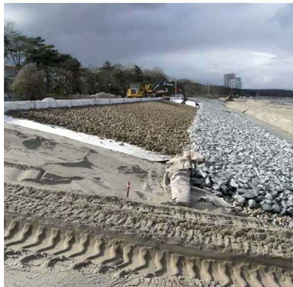
Bau einer Küstenschutzanlage (Foto: Ecologic Institut)
