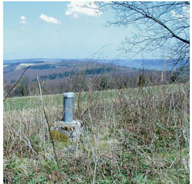
In Deutschland ist ein weites Netz von Grundwassermessstellen installiert, die regelmäßig Daten zum Grundwasserstand liefern. (Foto: Wolf-Peter von Pape / HLUg)
