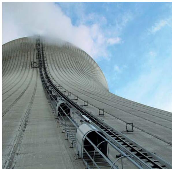
Wassereffiziente Kühlsysteme sind unabhängiger von Frischwasser und weniger empfindlich gegenüber Trockenperioden. (Foto: Kurt Michel / pixelio.de)
