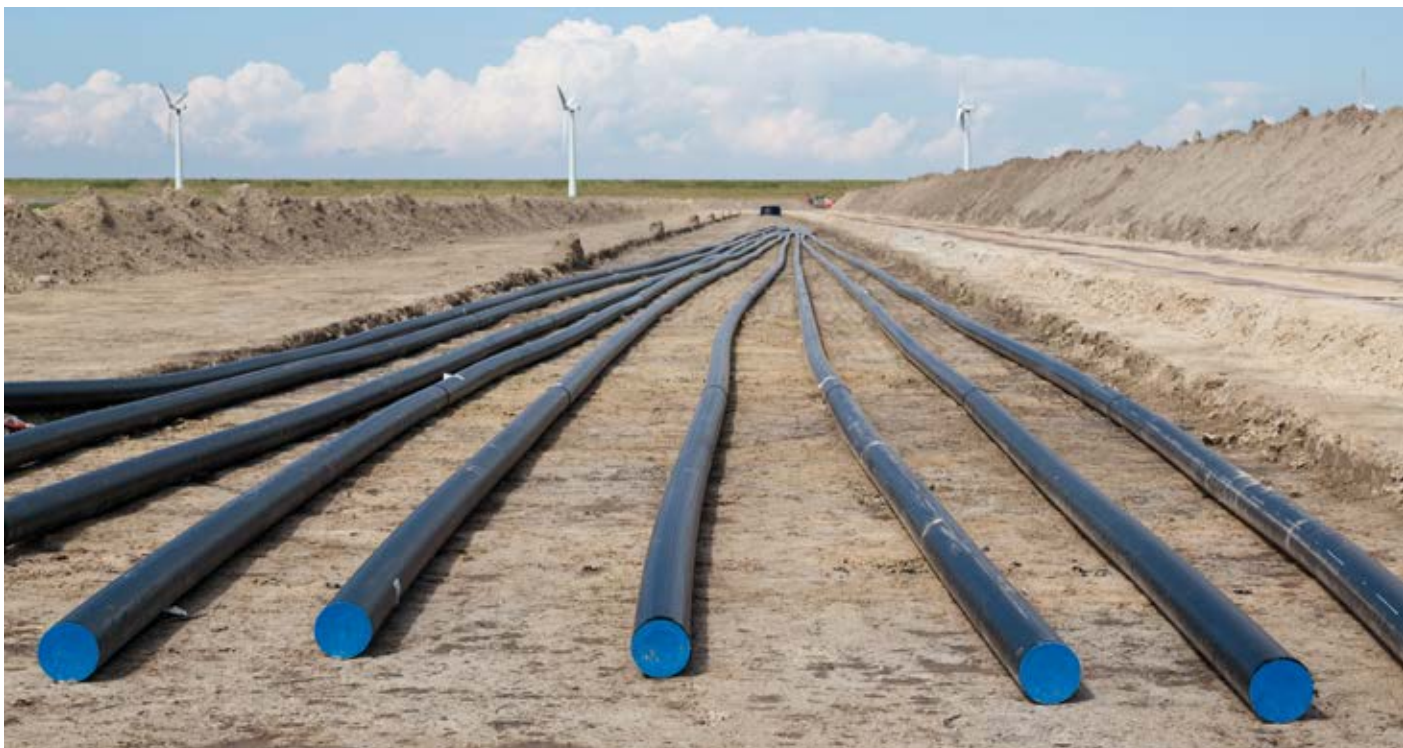
Netzausbau mit Erdkabeln – auch hierbei gibt es Umweltwirkungen.
