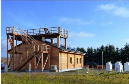
An sieben Messstationen in Deutschland misst das UBA fernab von Städten und Industrie die Hintergrundbelastung der Luft mit Schadstoffen, die sich grenzüberschreitend und global ausbreiten. An der Messstation in Zingst an der Ostseeküste wurde dafür Ende Juni 2015 ein neues Stationsgebäude in Betrieb genommen. Der Neubau wurde in Anlehnung an den Passivhausstandard und nach dem Bewertungssystem Nachhaltiges Bauen (BNB) für Laborgebäude realisiert. Ziel ist das
