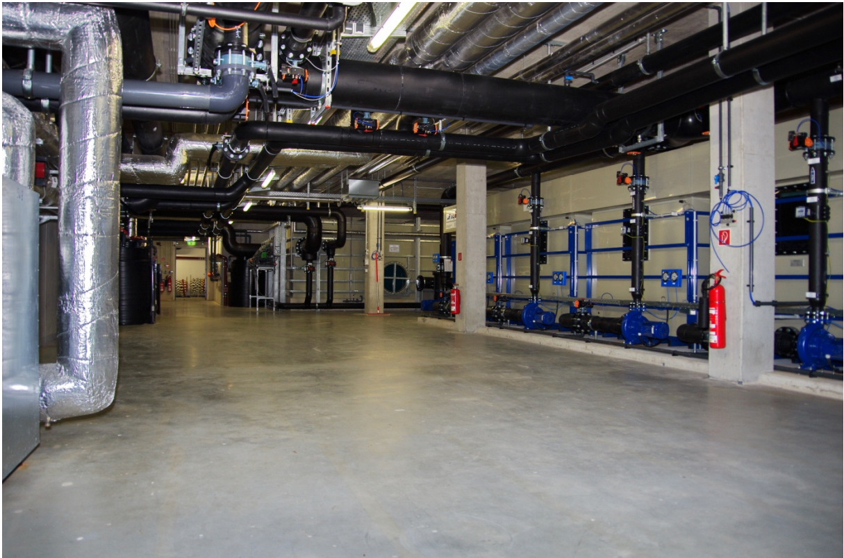
Abb. 1 Teilansicht der Beckenwasser-Aufbereitung in einem modernen großen Schwimmbad
