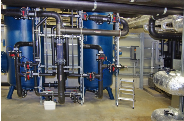
Abb. 5 Teil der Spülabwasser-Behandlungsanlage eines großen Bades
