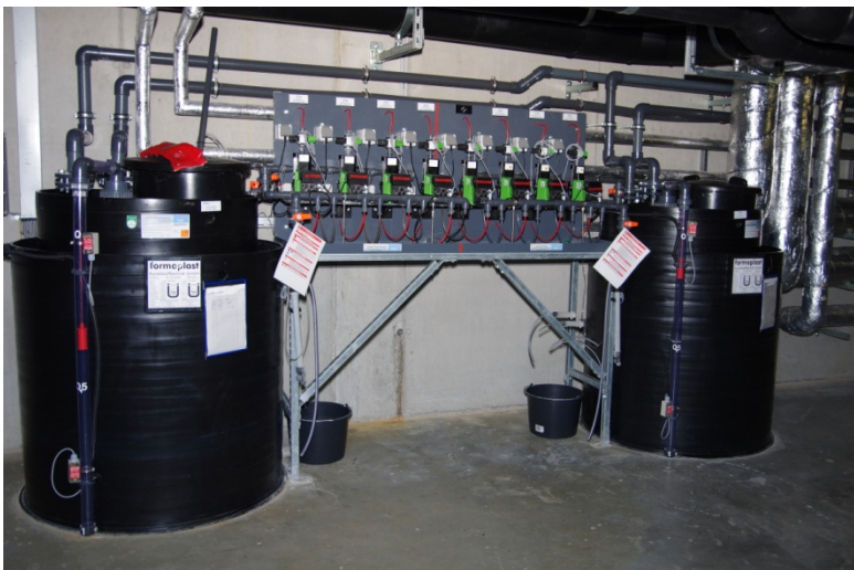
Abb. 6 Dosierstand für flüssige Aufbereitungschemikalien
