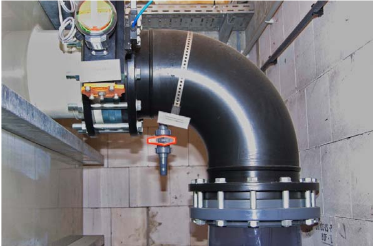
Abb. 7 Probennahmeahn am Spülabwasser-Rohr
