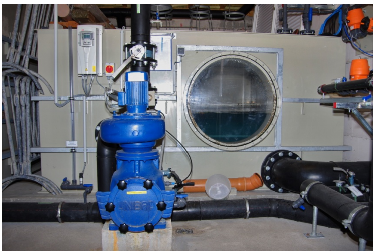
Abb. 2 Schwallwasserbehälter eines kleinen Schwimmbades
