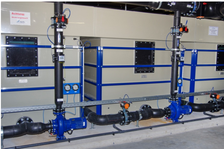
Abb. 4 Teil der Filtrationseinheit eines großen Schwimmbades
