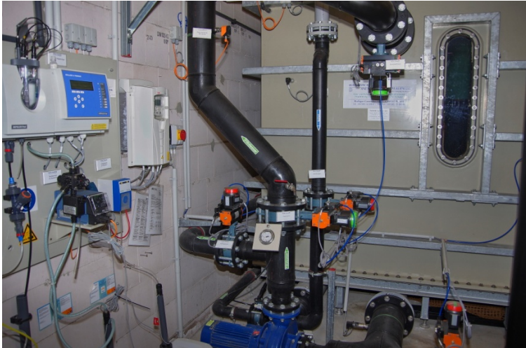
Abb. 3 Filtrationseinheit eines kleinen Schwimmbades, links im Bild Mess-, Regel- und Dosiertechnik des Aufbereitungskreislaufes
