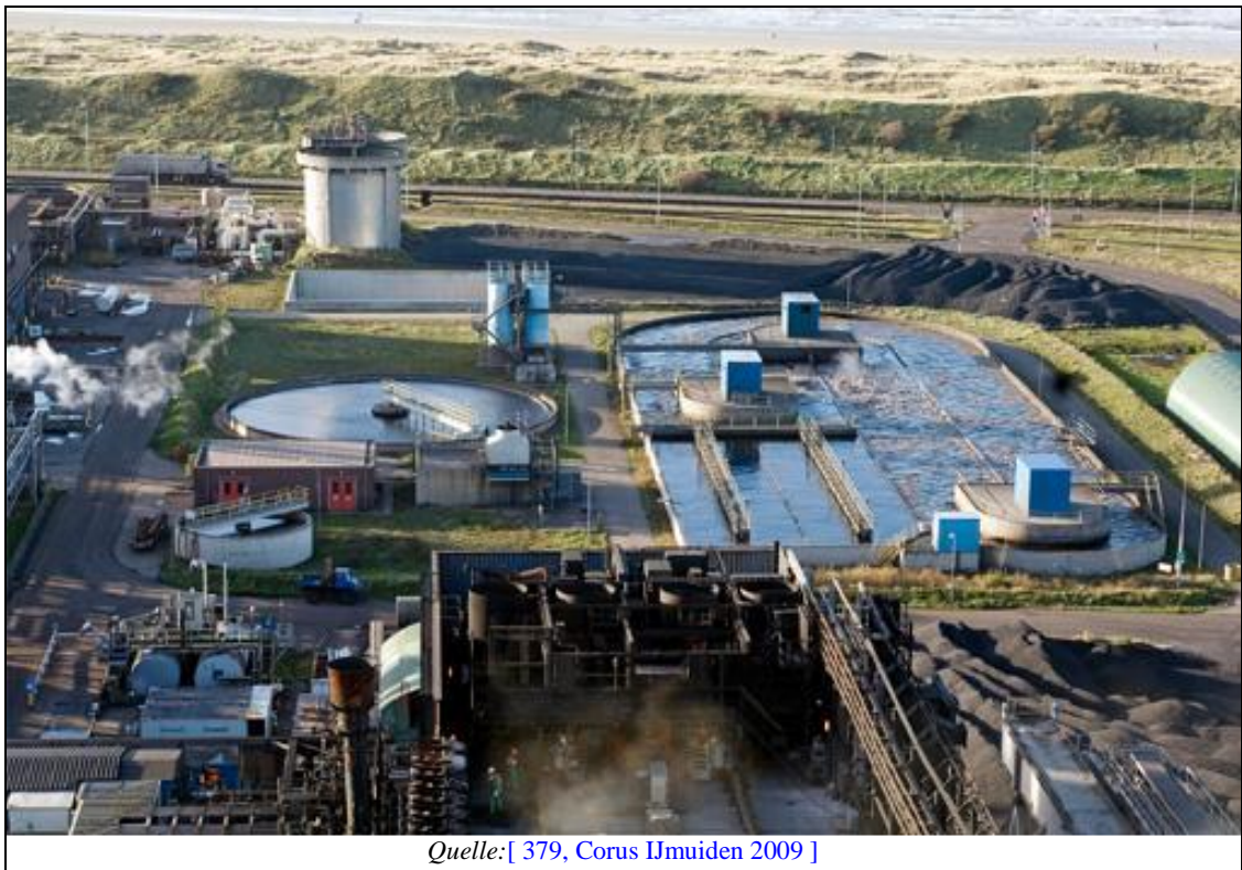
Abbildung 5.24: Luftaufnahme der biologischen Abwasserbehandlungsanlage von Corus, IJmuiden (Niederlande)
