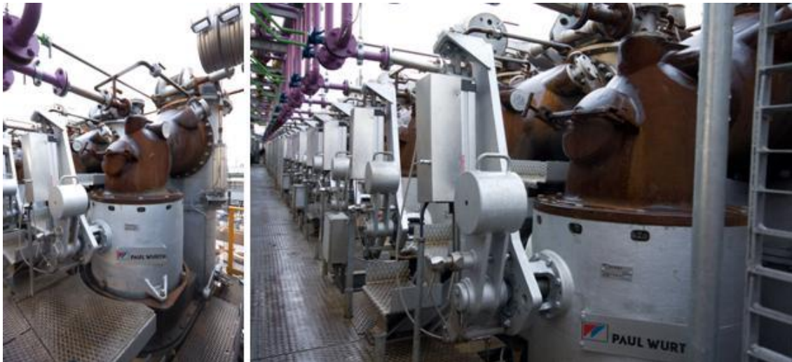
Abbildung 11.5: Ventile des Typs SOPRECO „Model 2“ an einer per Stampfverfahren befüllten Ofenbatterie
