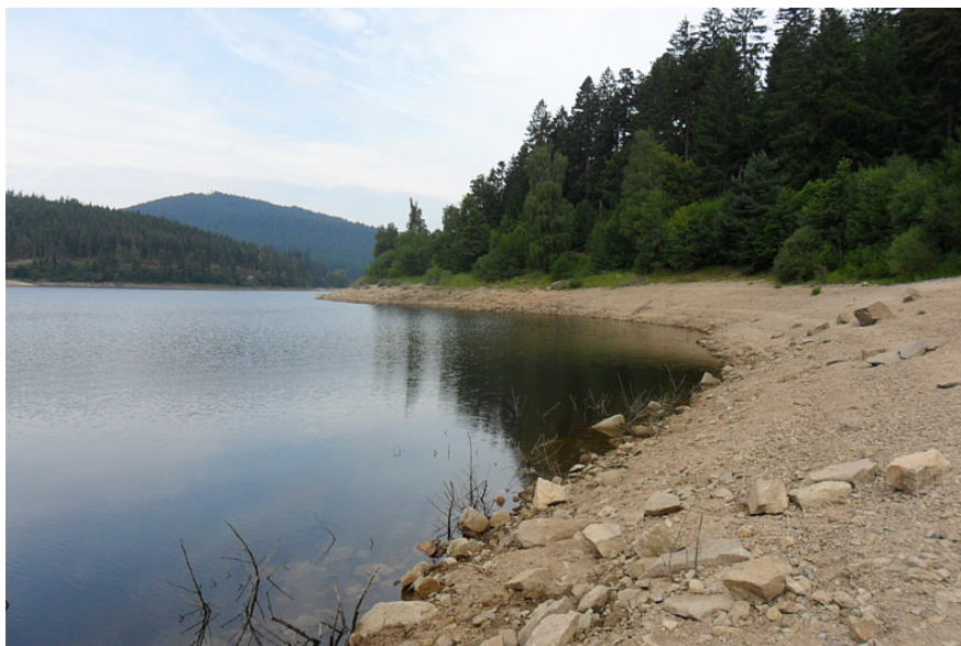
Schwarzenbachtalsperre (BW) © Eberhard Hoehn
