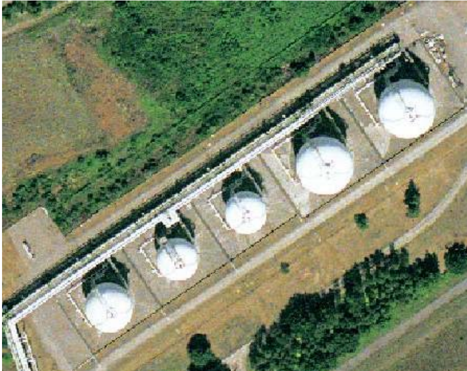
Abbildung 9.7.2.3: Kugeltanklager mit sogenannter Eierbecherfundamentierung im Chemiepark Marl.
