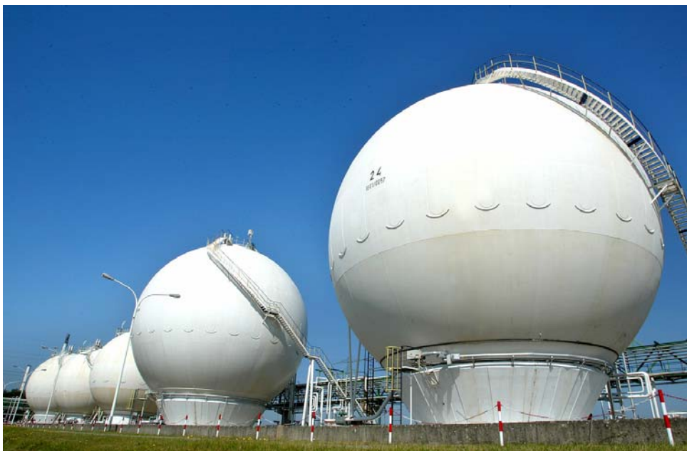
Abbildung 9.7.2.4: Kugeltanklager II des Chemieparks Marl
