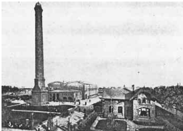
Abb. 1: Erste Müllverbrennungsanlage Deutschlands in Hamburg [3]
